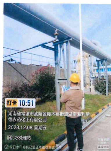
无组织废气: MF1040 (老污水站)
